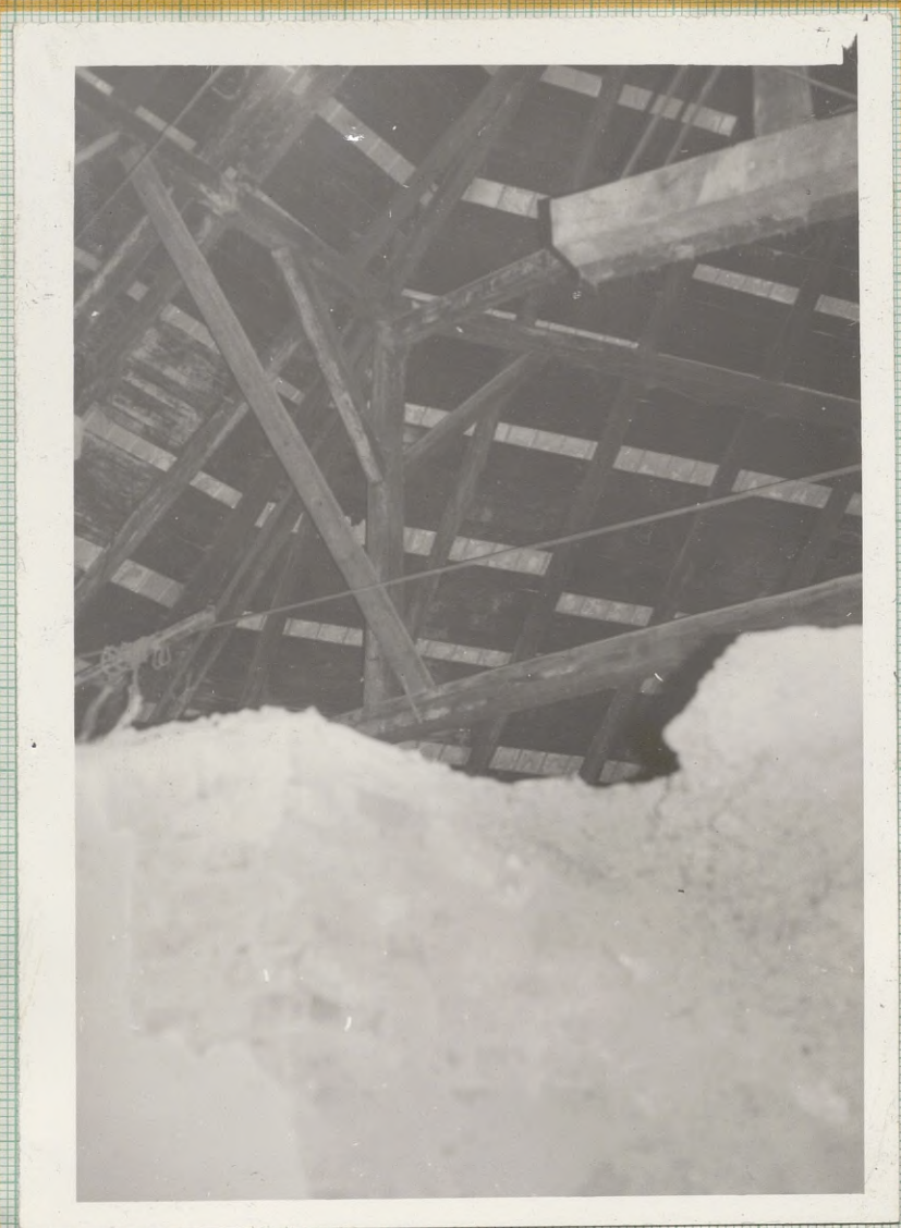
Zdi ustupo- valy, de- molice vnitřku pobracuje
