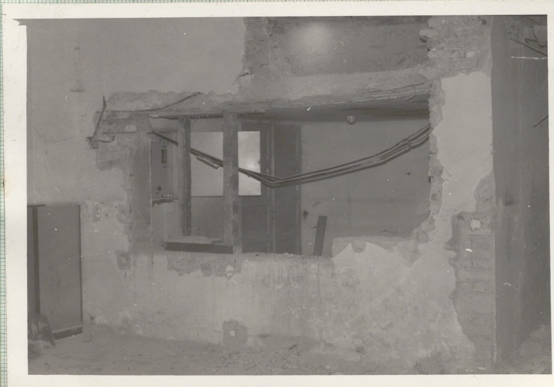
Tak byly odstra- ňovány vnitřní prvky
